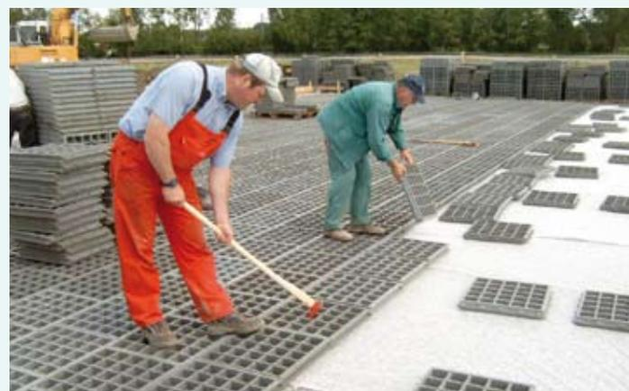
Das Verlegen der TTE<sup>®</sup>-Gitterplatte ist dank Fein-Netz und Verlegehaken kinderleicht. TTE<sup>®</sup> ist **ToTal Einfach**.
