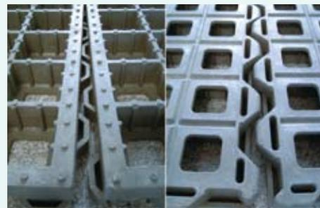
Die massive Verzahnung sorgt für optimale Druckverteilung, vermeidet Stolperstellen und dient als Puffer bei Materialausdehnung. Die beweglichen Fugen werden bei Benutzung der Fläche zwangsläufig leicht geöffnet und fördern die Entwässerung.
