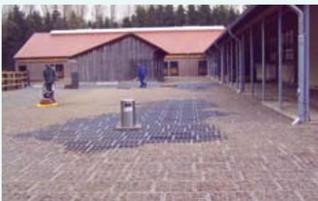
TTE®-Auslauf, befüllt mit Rundkiesel, vor dem Aufbringen der Trettschicht.
