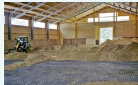
TTE®-Gitterblock speziell für Reithallen mit integrierten Wasserspeichern (effektiv 8 l/m<sup>2</sup>).
