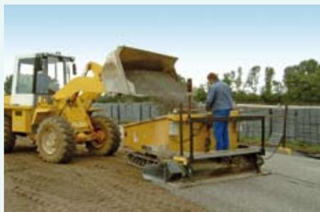
Bei großen Plätzen kann die Ausgleichsschicht mit einem Fertiger ausgeführt werden.
